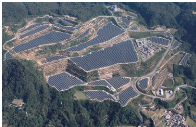
エネルギー自給100%に向け、メガソーラーや風力発電施設の建設が進みつつある
