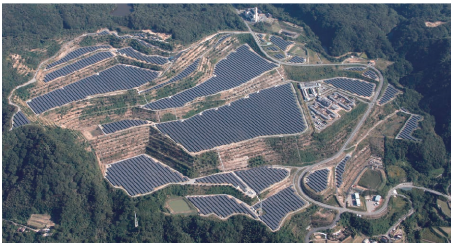
エネルギー自給100%に向け、メガソーラーや風力発電施設の建設が進みつつある
