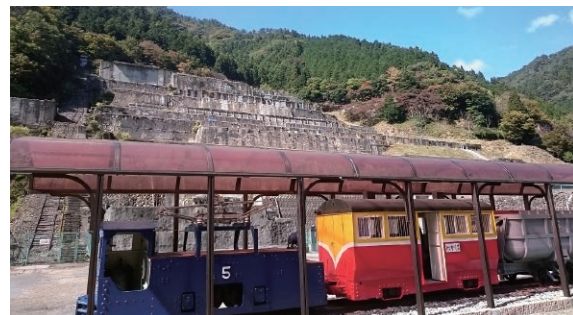
明延鉱山の選鉱施設として建設された神子畑選鉱場。産業遺産としての注目が高まっている
