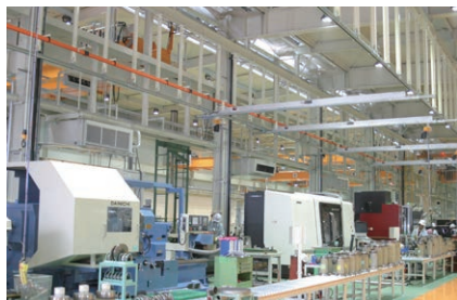
お客様の様々なご要望にお応えするため、新宮本社工場には最新設備が並びます
