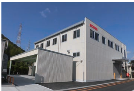
姫路工場に建設された生産技術センター
