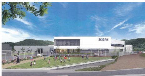
2020年竣工予定の新本社工場（イメージ画像）
