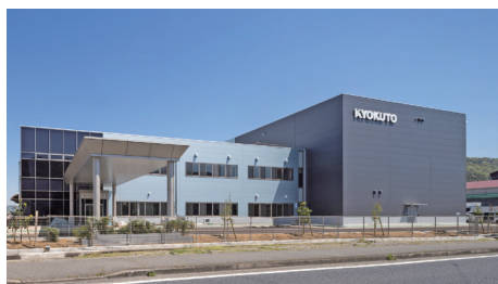
令和4年4月完成 神岡新工場
